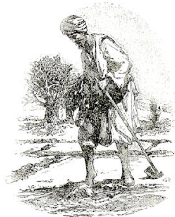
KANALEN GRAVEN MET DE VOETEN.
