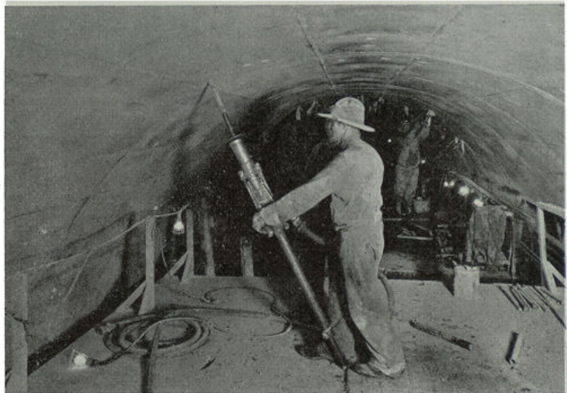
... Drillboren dreunden door de onderaardsche gangen...
