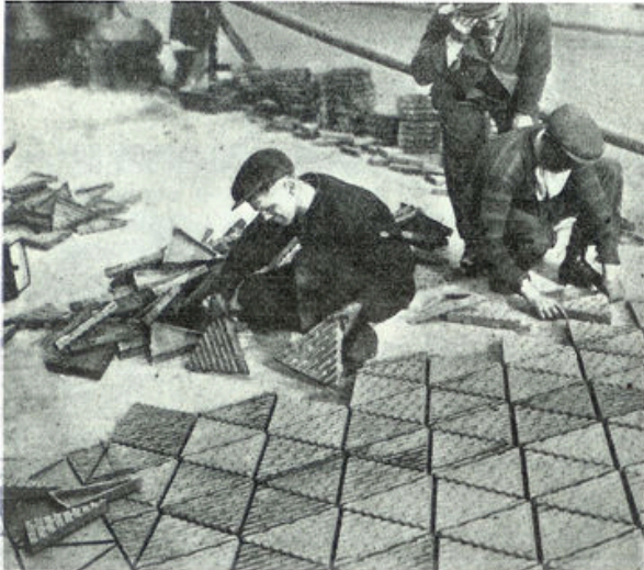
Een nieuw soort wegbedekking wordt in Engeland beproefd. Ze bestaat uit driehoeken van ijzer, die nauwkeurig in elkaar passen. Het slipgevaar wordt hierdoor tot een minimum beperkt.
