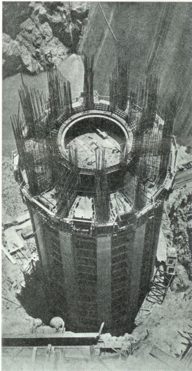
Een machtig waterwerk nadert thans zijn voltooiing in de Coloradorivier van Z.-W. Amerika. De kracht, waarmee het water door zijn bedding stroomt, zal omgezet worden in elektrische energie. — Onze foto toont een der vier torens, elk 120 M. hoog, waardoor het water zal geleid worden, en welks kracht zal gebruikt worden voor electriciteit-ontwikkeling.
