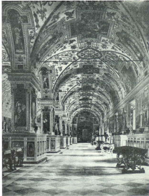
Een blik in de prachtige bibliotheekzaal van het Vaticaan, waarvan een gedeelte is ingestort en waarbij ook menschenlevens te betreuren vielen. De drie pilaren, met een x gemerkt, konden blijkbaar den last niet meer dragen en bezweken, waardoor zooveel schoons en kostbaars onder het puin bedolven werd.
