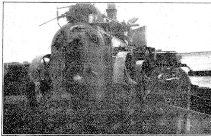
De locomobiel en de machine om het veen fijn te maken. Let op de uitstreamingsbuis achteraan.
