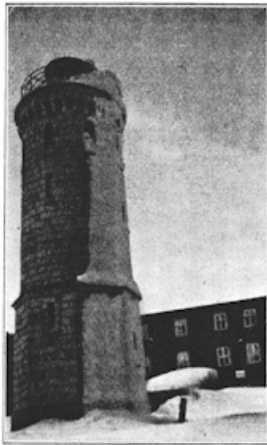
Uitzichttoren en hotel op den Brocken.
