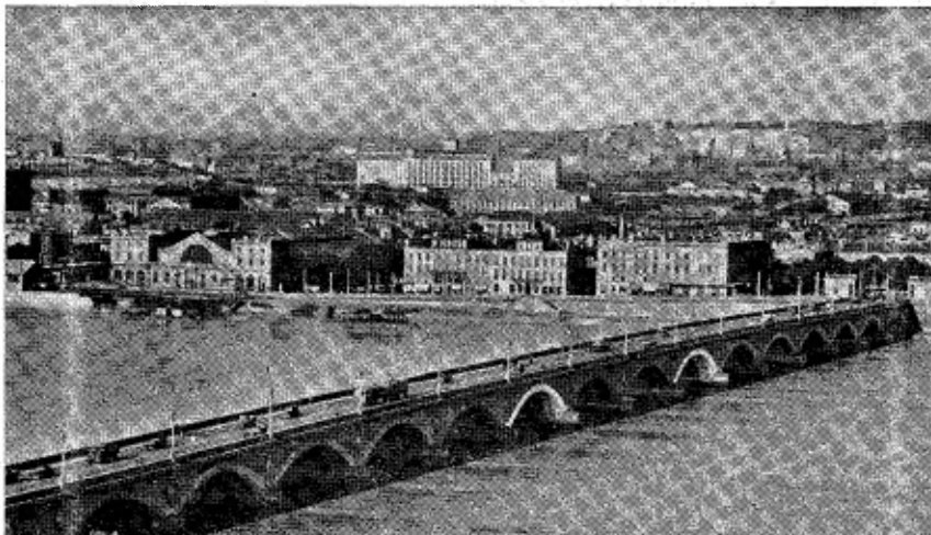
Bordeaux. De brug over de Gironde. Le pont de pierre.
