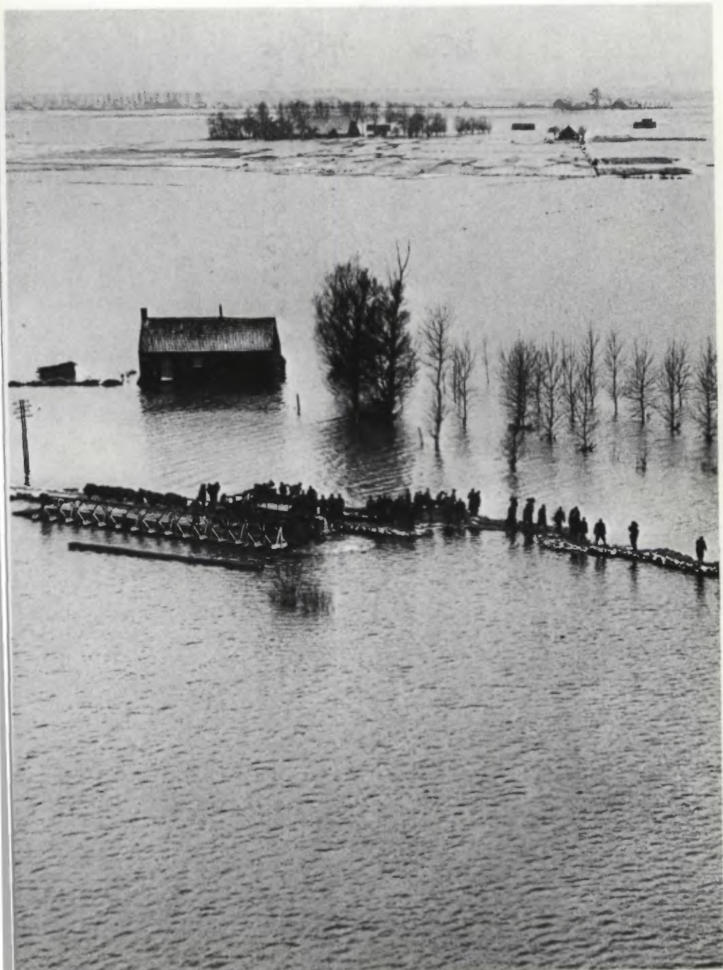
Angstig-smalle zandzak-dijkjes nog, maar het gat is dicht, en de rest gaat dan veel makkelijker.
