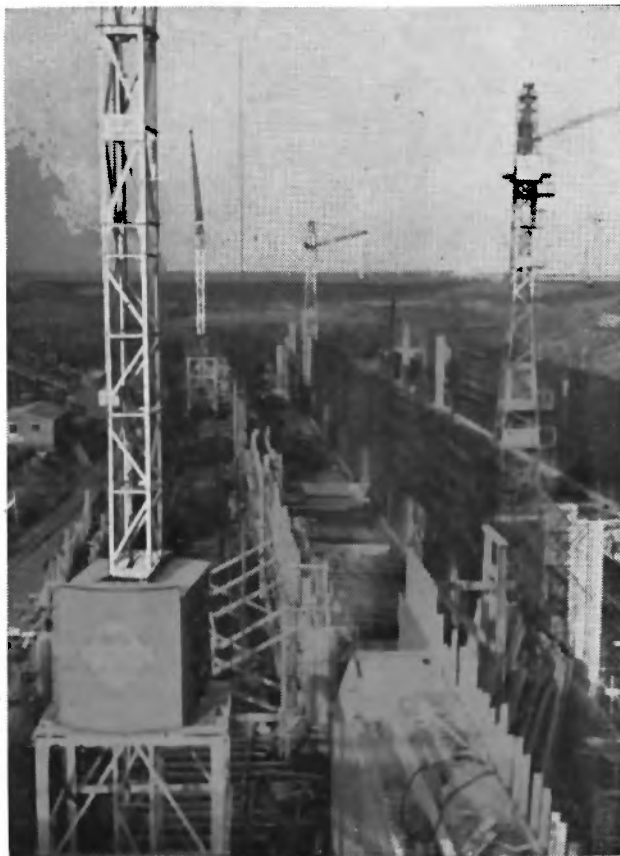
Stutspuit voor de nieuwe Eemskanaal-zeesluizen, die 125 meter lang worden en 16 meter breed. Naast de grote stut is ook een kleinere gemaakt, om het binnendringen van zout water naar het binnenland zoveel mogelijk te beperken. (Cliché: De Eemsbode, Delfzijl)
