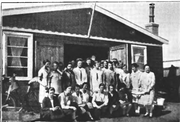
Voor 't Kampeergebouw
